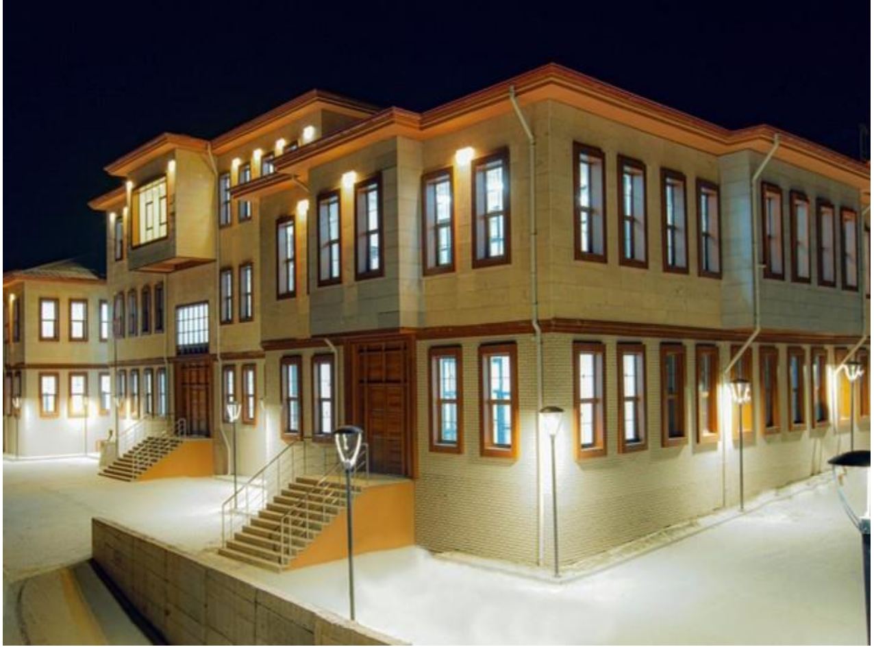
1-KORGAN İLÇESİ HÜKÜMET KONAĞI VE ADLİYE BİNASI YAPIM İŞİ
